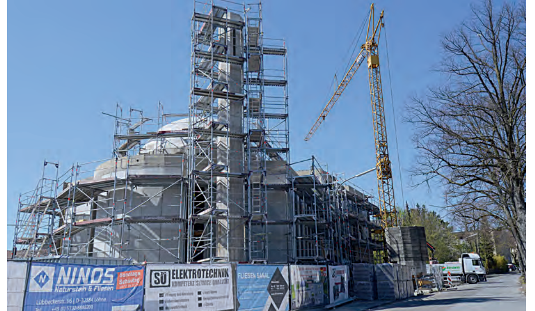
İnşaatı hızla devam eden DİTİB Bünde Yeni Cami
