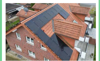
Komple Güneş Enerjisi Çözümleri
